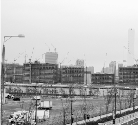
晴海オリ・パラ選手村建設現場 (豊洲市場側から撮影 3/23)
